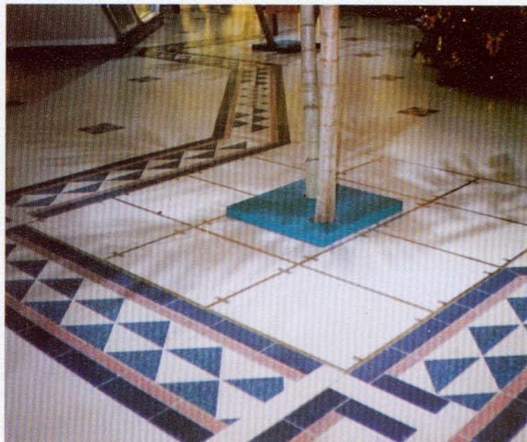
Flächenabdeckung aus 3 Traversen und 12 Deckeln
